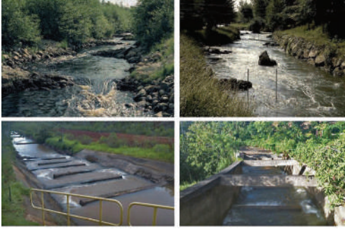
Figura 2. Canal de "piracema" construido en Itaipu presentando alta complejidad morfológica e hidrológica para facilitar el pasaje de peces (Fotos: Claudio Baigún).
