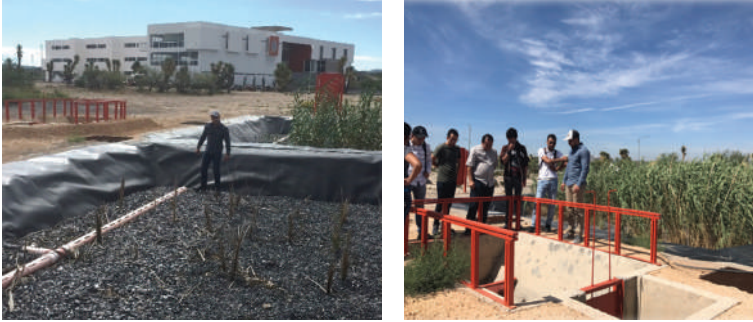
Figura 6. Humedal construido del Campus Salinas (UASLP). Fuente: Elaboración propia.
